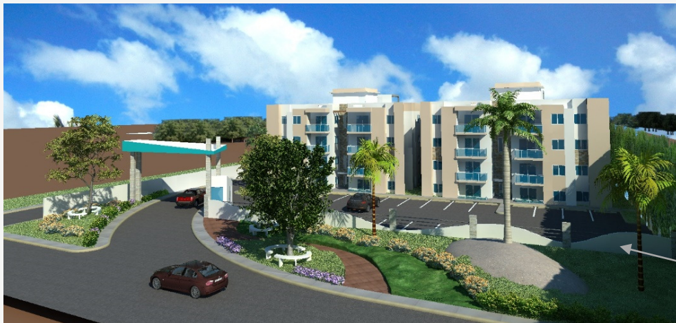
Garita y portal de entrada
